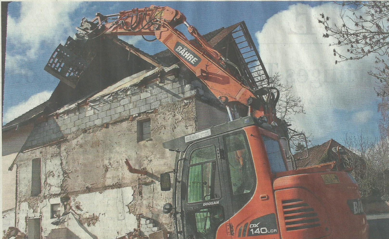
Baggerführer Jurij Gerdt hat mit der Baggerschaufel zielgenaue Arbeit abzuliefern.
